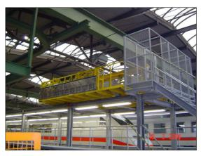
Auch die Lösung mit zwei mobilen, vom Dach abgehängten Dacharbeitsbühnen war viel zu kostspielig. Genau diese Lösung ist in neu erbauten ICE – Betriebswerken jedoch Standard.
